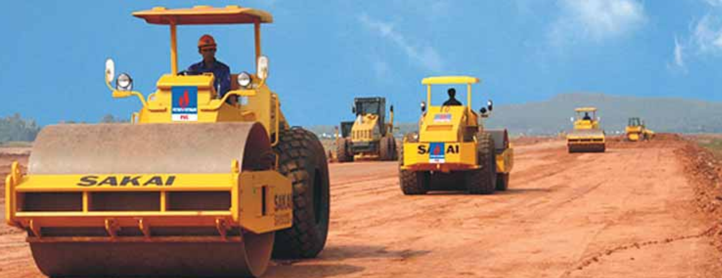
DỰ ÁN SAN LẤP MẶT BẰNG KHU LIÊN HỢP LỌC HÓA DẦU NGHI SƠN
