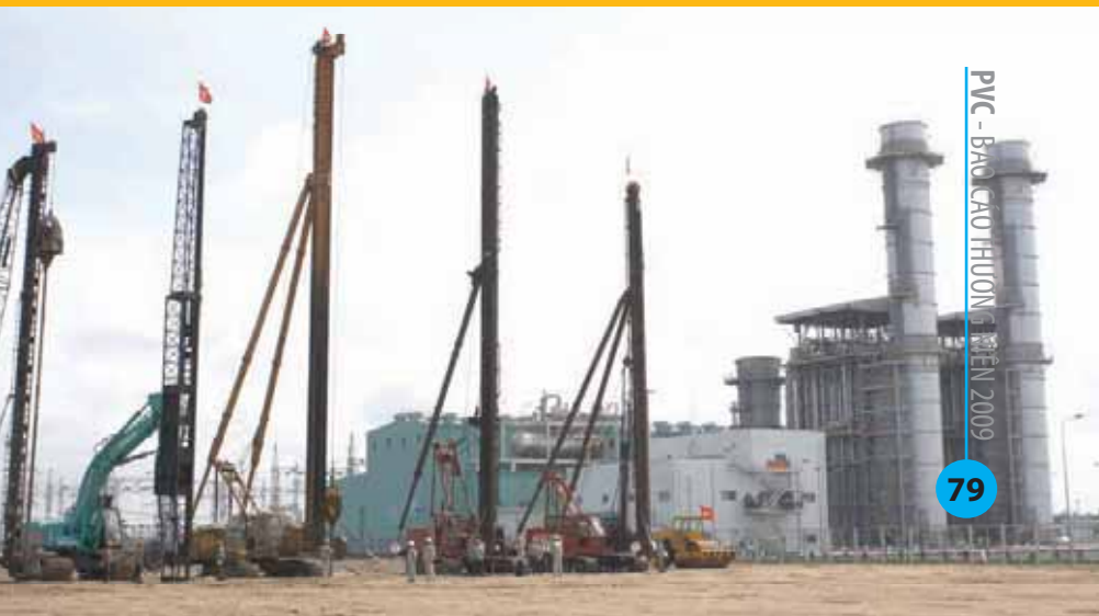
DỰ ÁN XÂY DỰNG NHÀ MÁY NHIỆT ĐIỆN NHƠN TRẠCH 2
