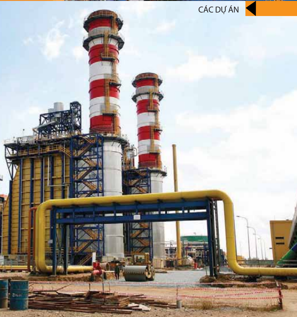
DỰ ÁN NHÀ MÁY NHIỆT ĐIỆN CÀ MAU
