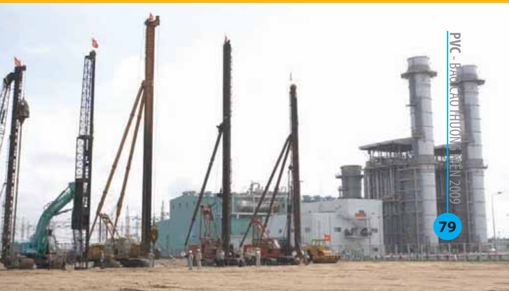
DỰ ÁN XÂY DỰNG NHÀ MÁY NHIỆT ĐIỆN NHƠN TRẠCH 2
